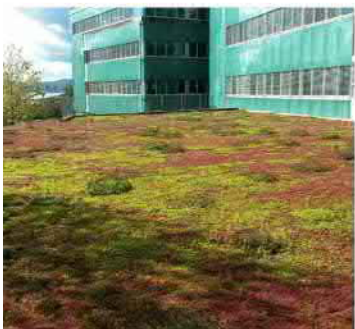
Esimerkkejä ekstensiivisistä viherkatoista, joilla erityyppisiä maksaruohomattoja, sekä erilaisista kansipihojen ratkaisuista.
