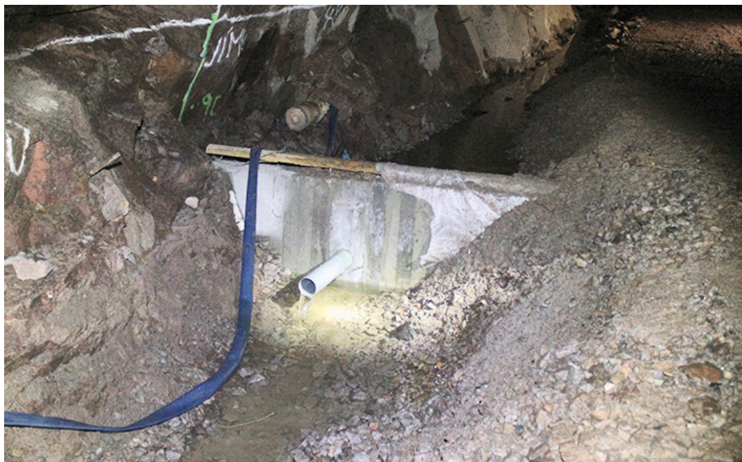
Kuva 11: Mittapato mittaa vuotovesiä, ROCKPLAN
