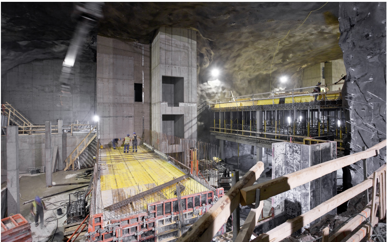
Kuva 4: City-Centerin rakennustyömaa, työt käynnissä, 2010, ROCKPLAN kuva-arkisto, Juha Nenonen
