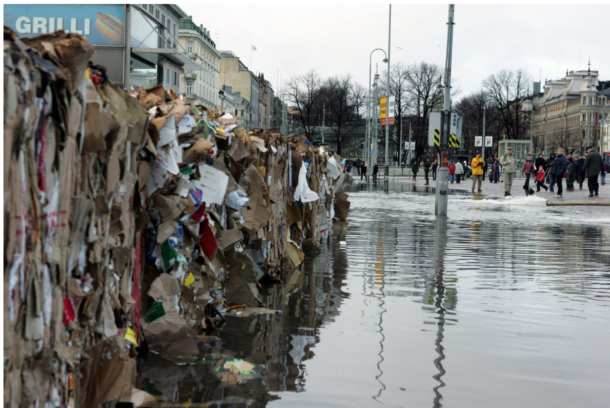
Kuva 7: Meriveden tulvimista Kauppatorille estettiin paaleilla, 2005, STT, Lehtikuva, Matti Björkman
