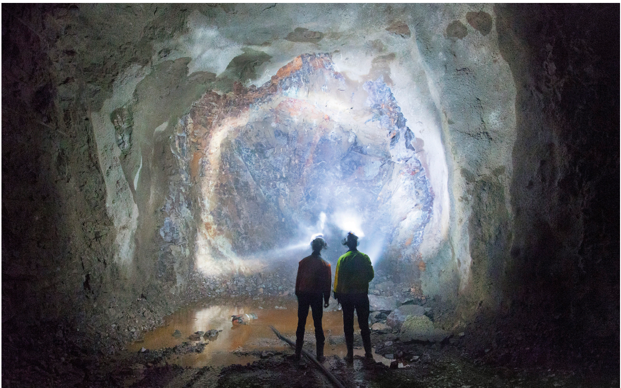
Kuva 5: Geologit tarkistavat Länsimetron tunneliperän louhintäjälkeä, ROCKPLAN kuva-arkisto, Juha Nenonen
