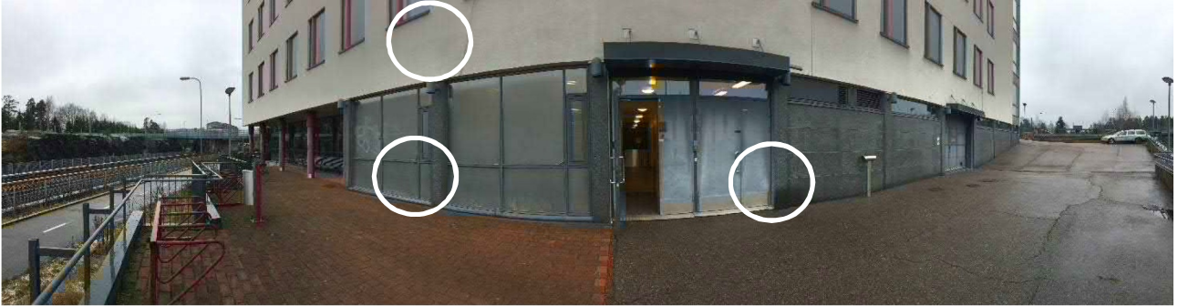
Kuva 1: Mittauspisteet P1...P3, näkymä radalta pois päin. Mittauspisteet olivat rakennuksen sisällä.
