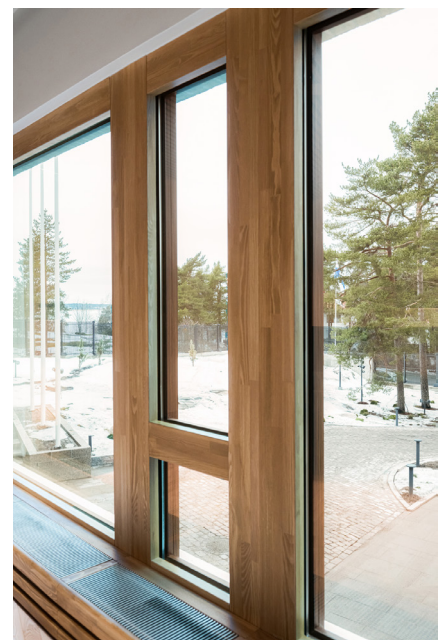
Kuvassa pääaulan kaarevalta ikkunaseinältä avautuu merinäköala Laajalahdelle. Ikkunoiden alaosan lattiaan alle on integroitu patteri ja korotettu lattia. Kuvat: Zentuvo Finland Oy
