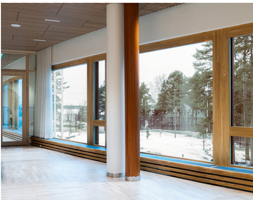
Kuvassa pääaulan kaarevalta ikkunaseinältä avautuu merinäköala Laajalahdelle. Ikkunoiden alaosan lattiaan alle on integroitu patteri ja korotettu lattia. Kuvat: Zentuvo Finland Oy
